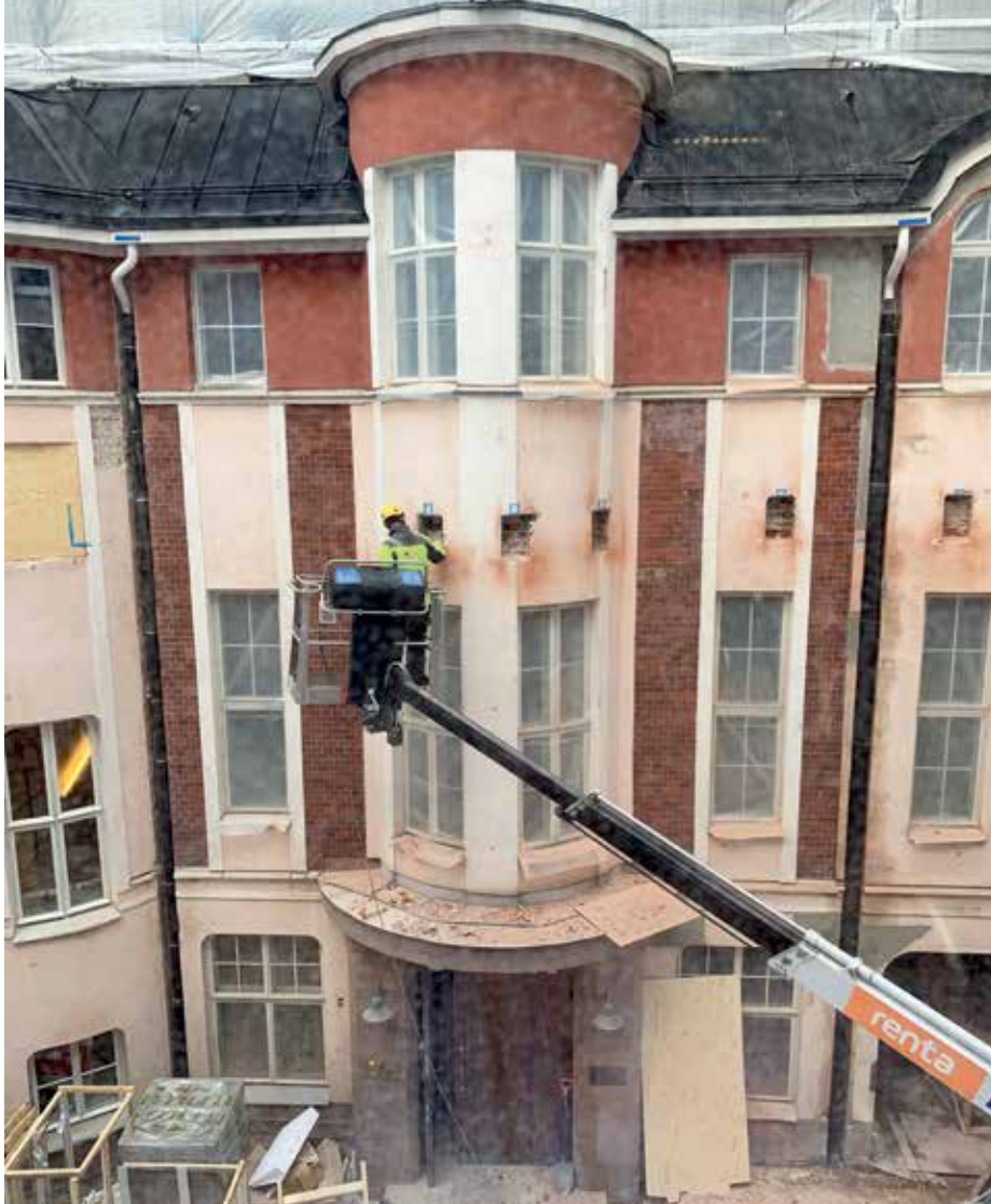
Infästningarna för glastaket är ett handarbete som kräver stor precision.
